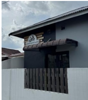
Gambar 1. Gedung Lembaga Jawwada
